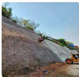
Estabilización de Taludes
