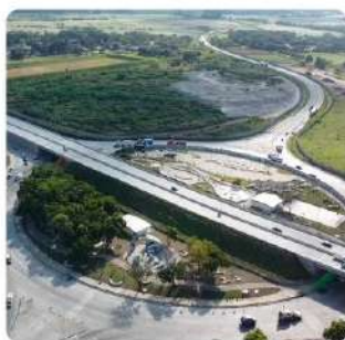
Construcción de By Pass
